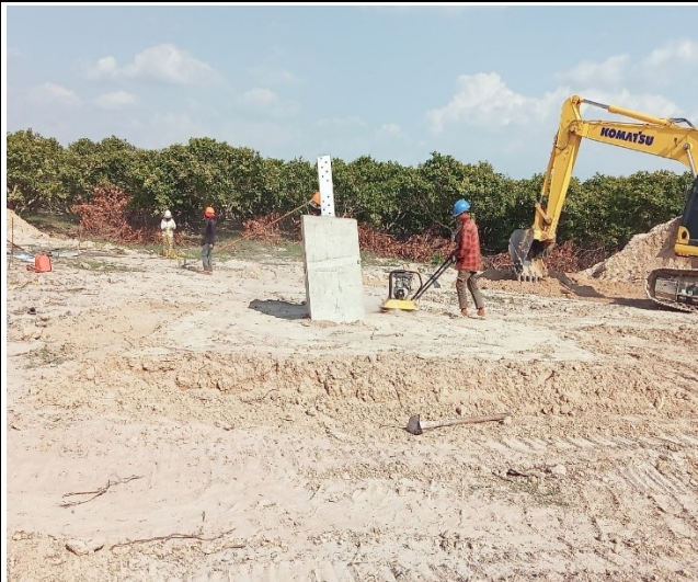
Backfill leg B, D
