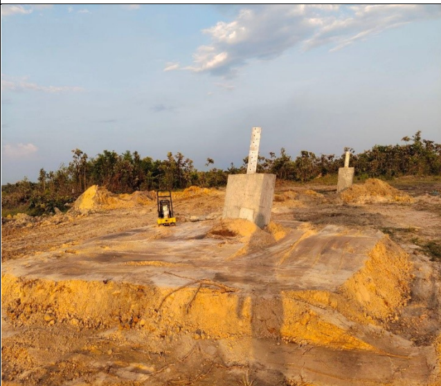
Backfill leg B, C
