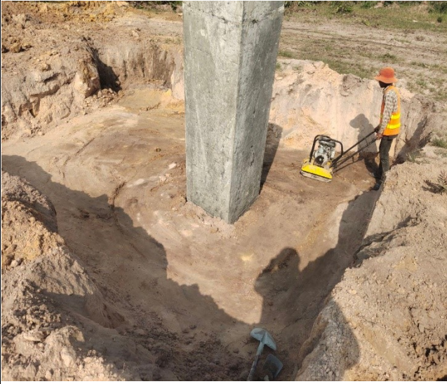
Backfill leg B, C
