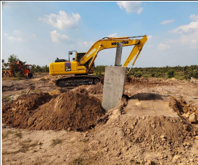
Backfill leg B, C
