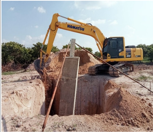
Backfill leg B, D
